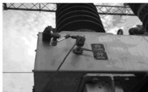
35KV SF6 开关传感器安装
