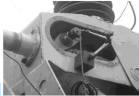
110KV SF6 开关传感器安装
