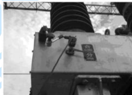
35KV SF6 开关传感器安装
